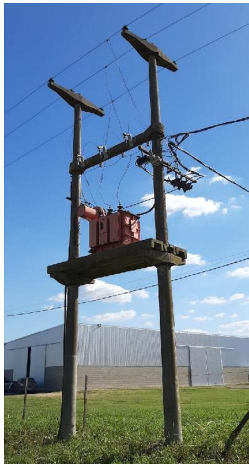
Imagen 10.7 - Subestación transformadora aérea progresiva 8380.
